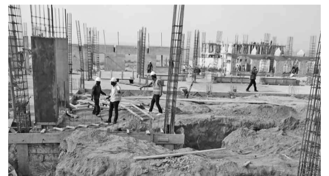
Les ouvriers en plein chantier
