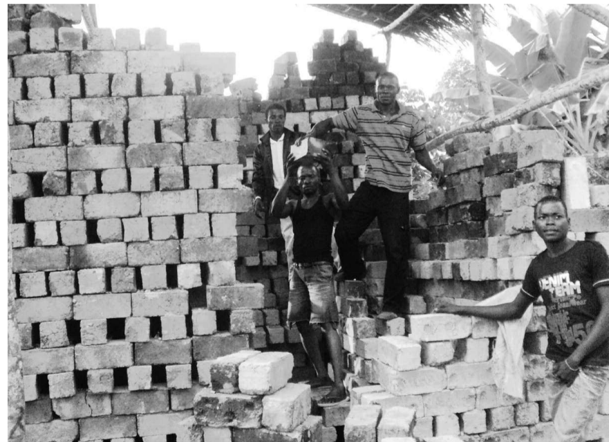
Un four à briques de terre cuite à Impfondo
