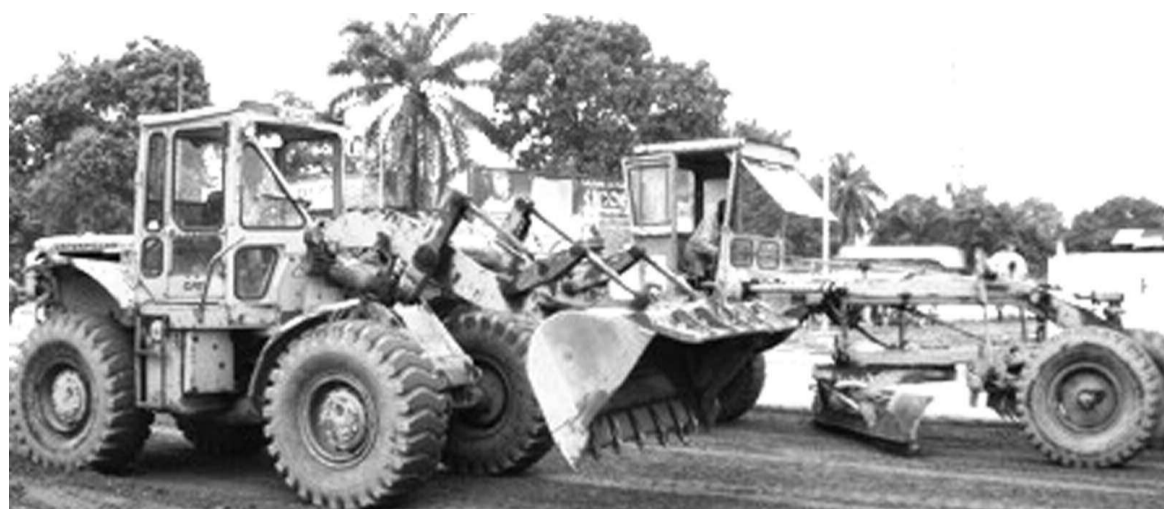
Travaux de réhabilitation de routes à Kinshasa
