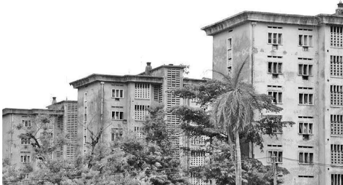
Les immeubles concernés par l'instruction de la primature
