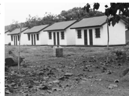
Les bâtiments du centre bio-agricole
