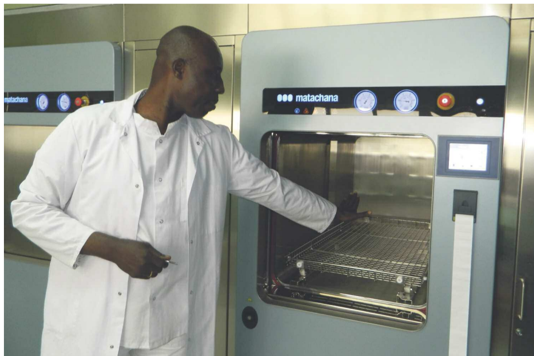
La salle de stérilisation
