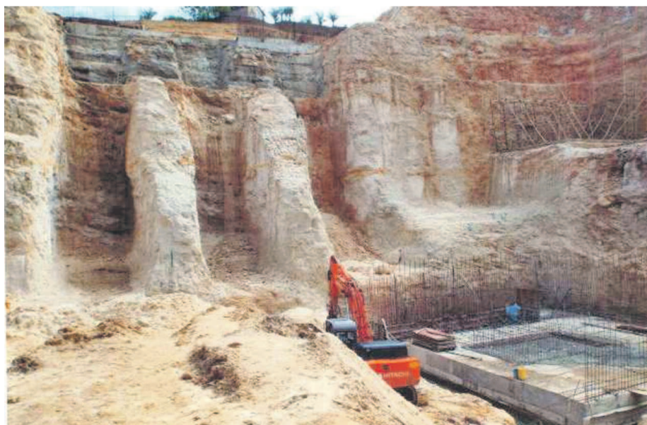
Une vue du barrage de Kakobola
