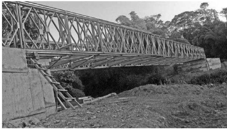
Un pont en construction sur la rivière Libama entre Yaya et Komono. Crédit-photo adiac
