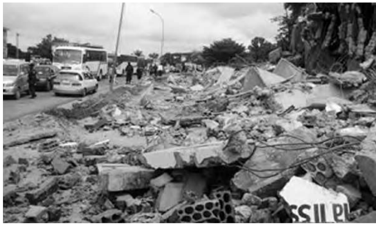
Les débris des matériaux de construction après la démolition
