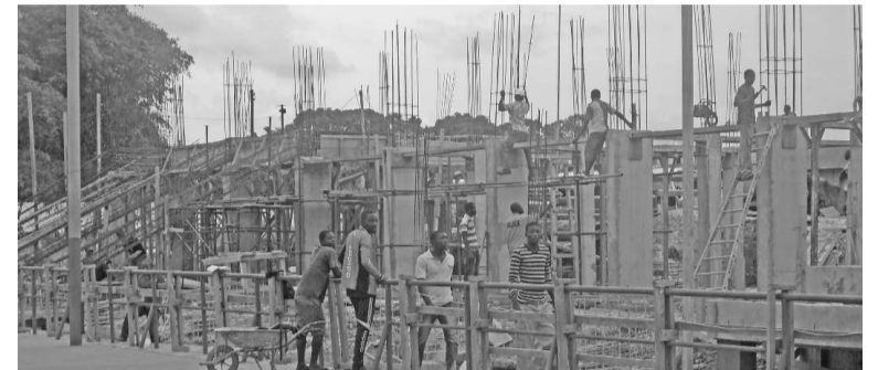
Le stade d'Ornano en construction
