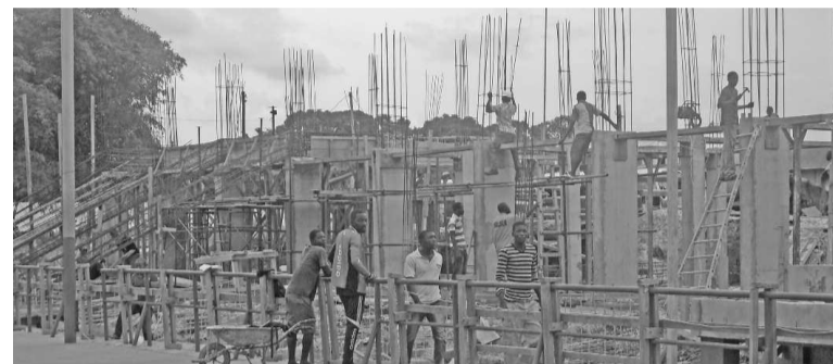
Le stade d'Ornano en construction
