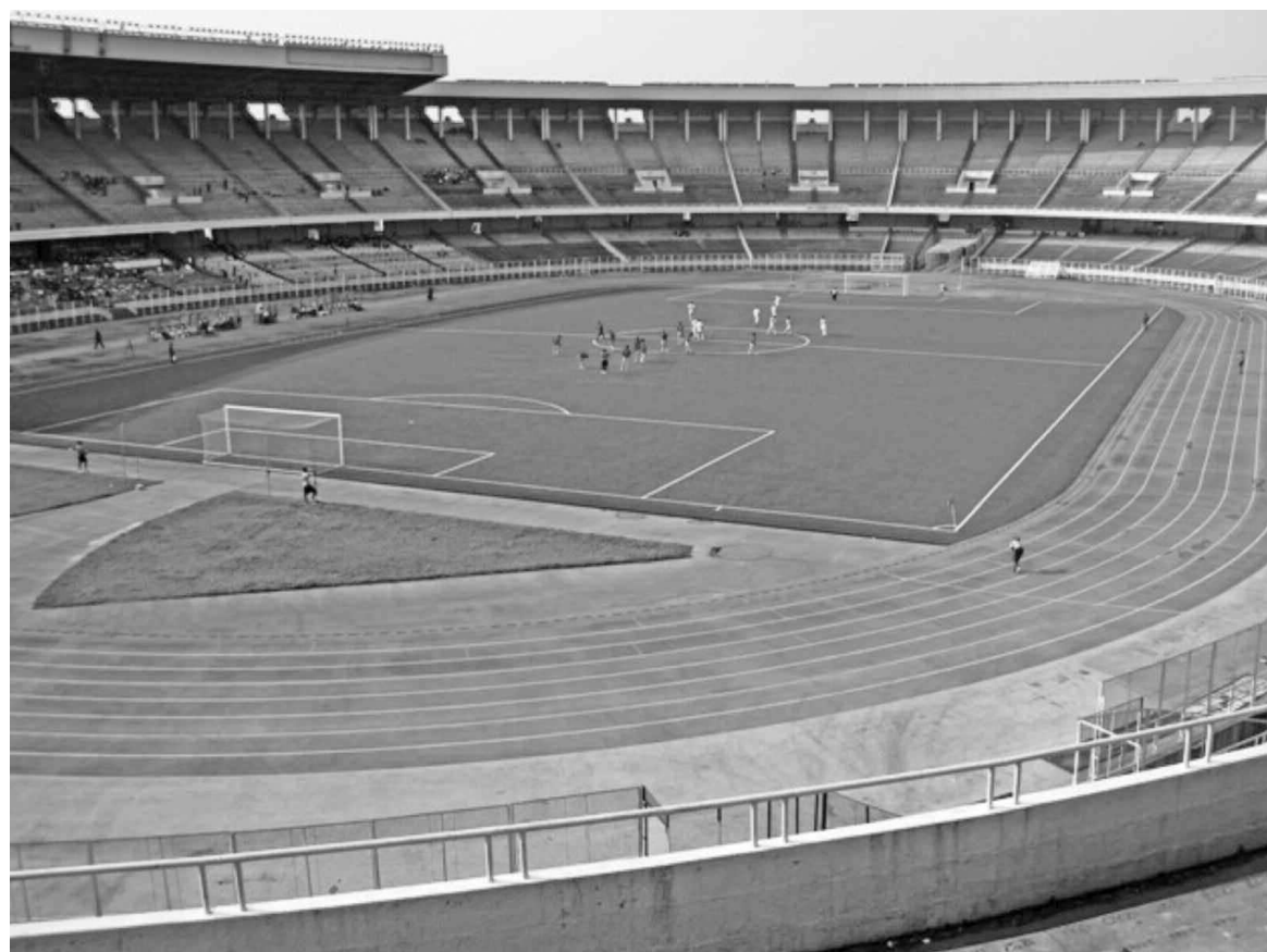
Le stade des Martyrs de Kinshasa sera fermé durant 13 mois pour des travaux de réhabilitation
