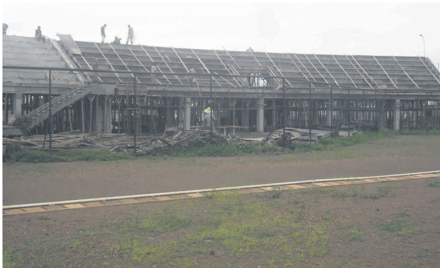
Une partie des gradins en construction (© Adiac).
