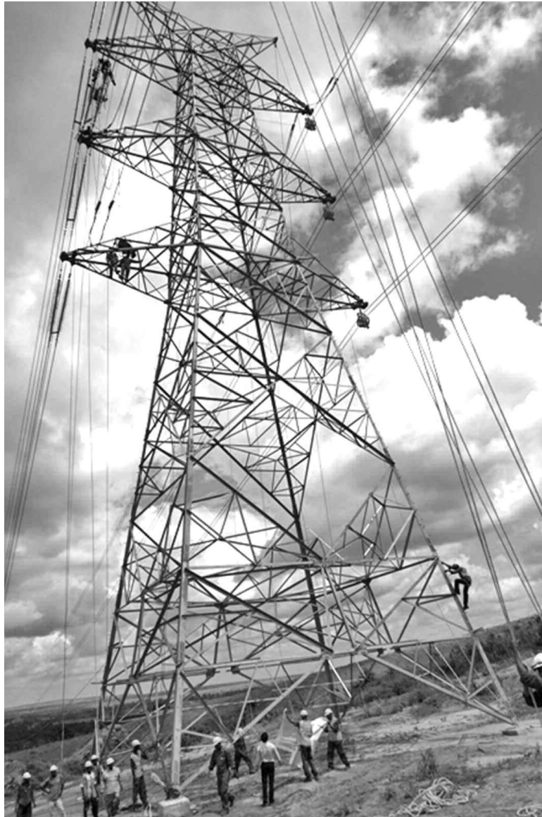
Construction de la deuxième ligne Inga-Kinshasa
