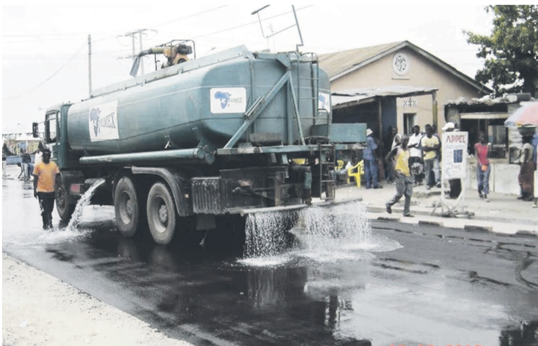
Travaux de réhabilitation d'une route à Kinshasa
