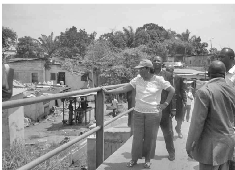
Émilienne Raoul visitant les travaux de la rue Maloukou/Bouzala. crédit photo Adiac
