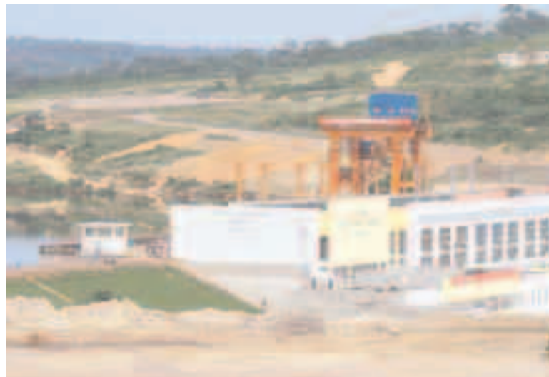
Vue arrière du barrage d'Imboulou
