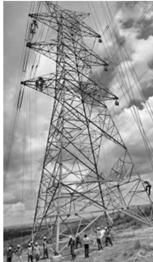
Construction de la ligne haute tension Inga-Kinshasa
