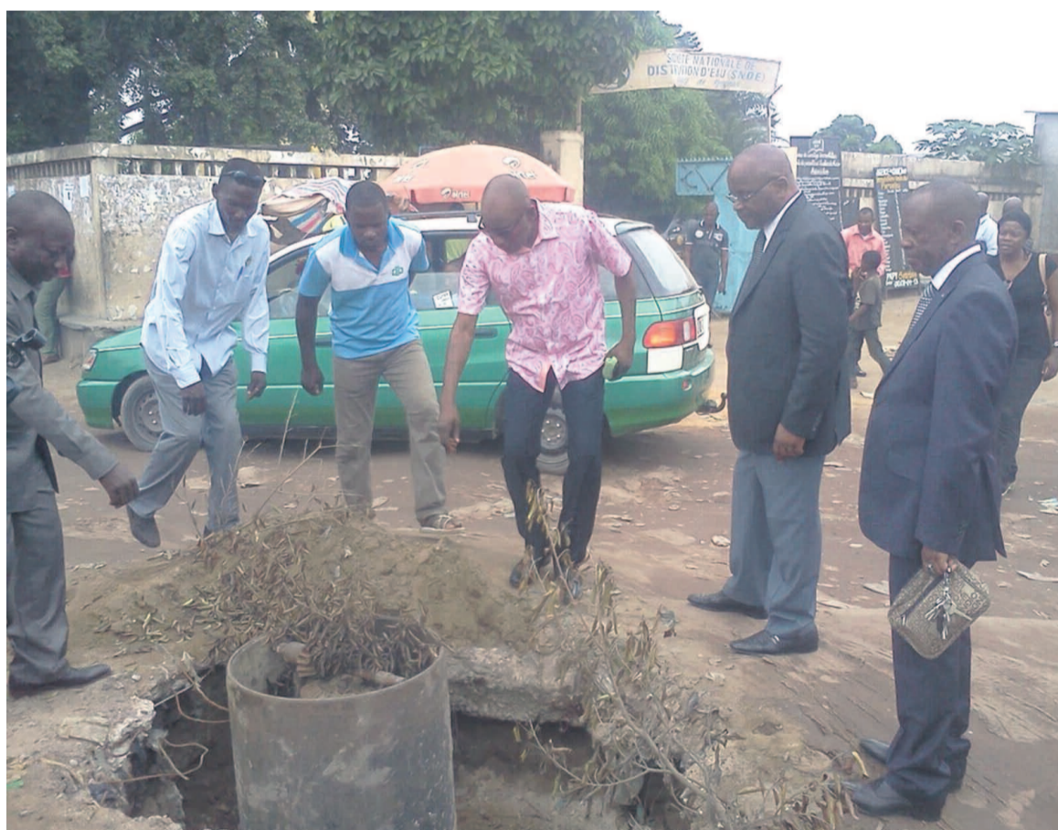
Vue de la vanne où une fuite d'eau a été constatée (© DR)
