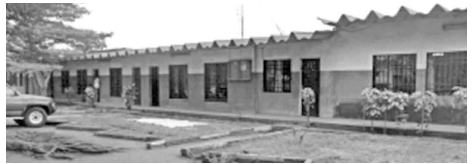
Les installations de l'antenne de Lemba de l'AFCK
