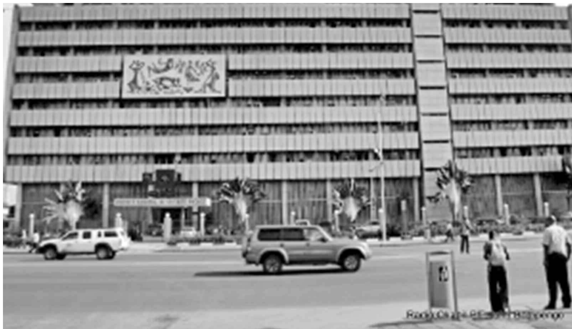
Siège de l'INSS sur le Boulevard du 30 Juin à Kinshasa
