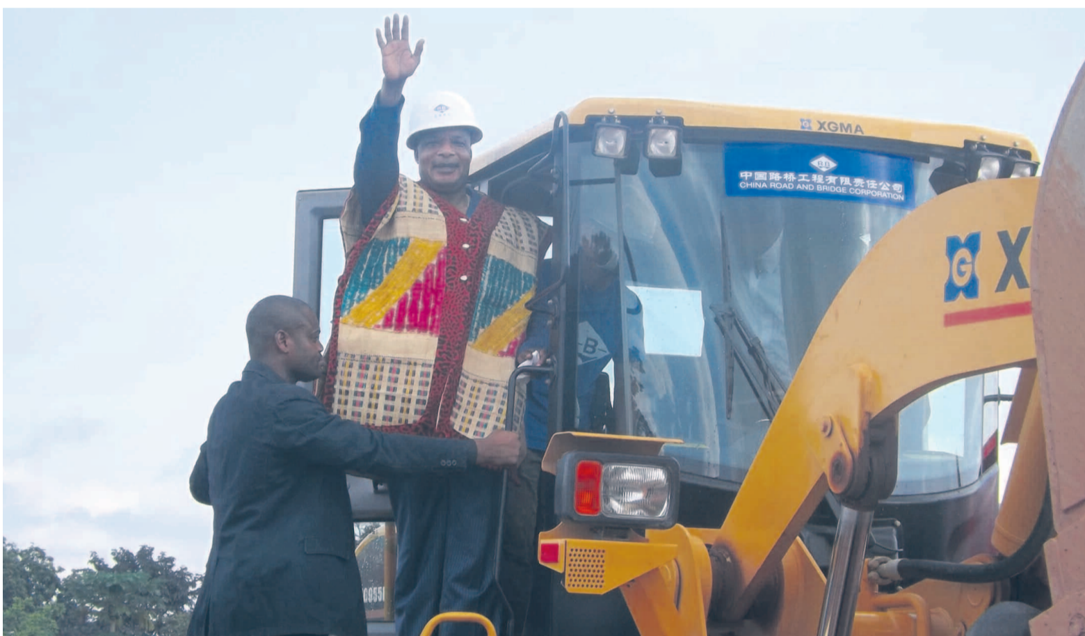
Le chef de l'État a donné le coup d'envoi des travaux à bord de cet engin
