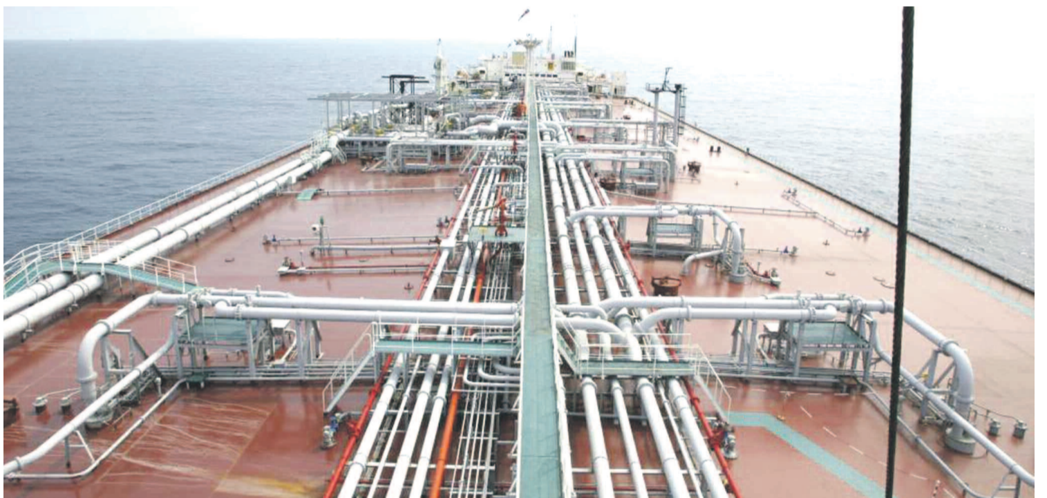
Un terminal de stockage pétrolier au large de l'Angola
