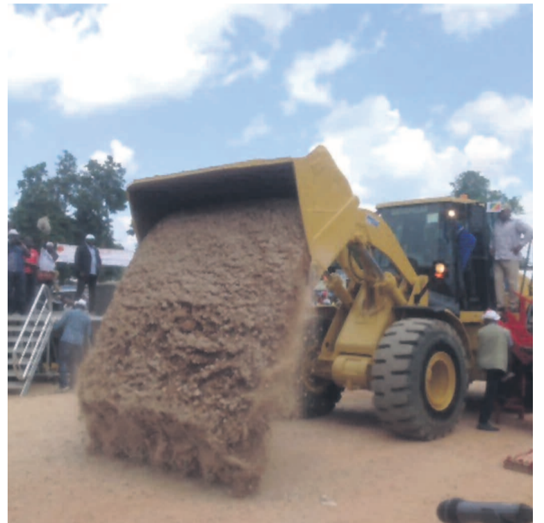
Lancement des travaux
