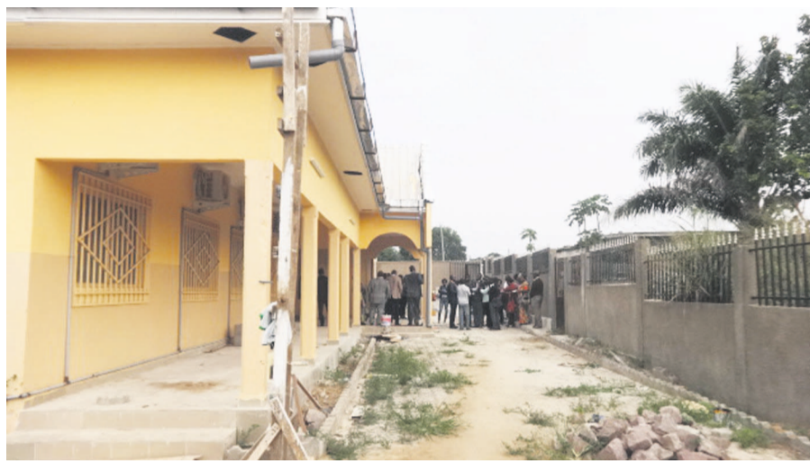
Le chantier du centre intégré de Mayanga. (photo Adiac)
