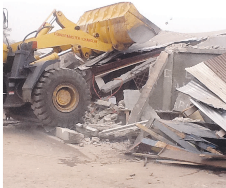
Un engin en pleine opération
