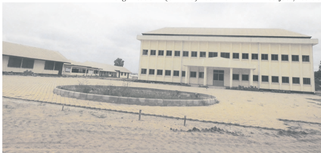
L'Institut de Loudima vue de façade
