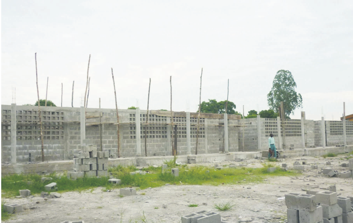
Le nouveau bâtiment en construction, crédit photo «Adiac»
