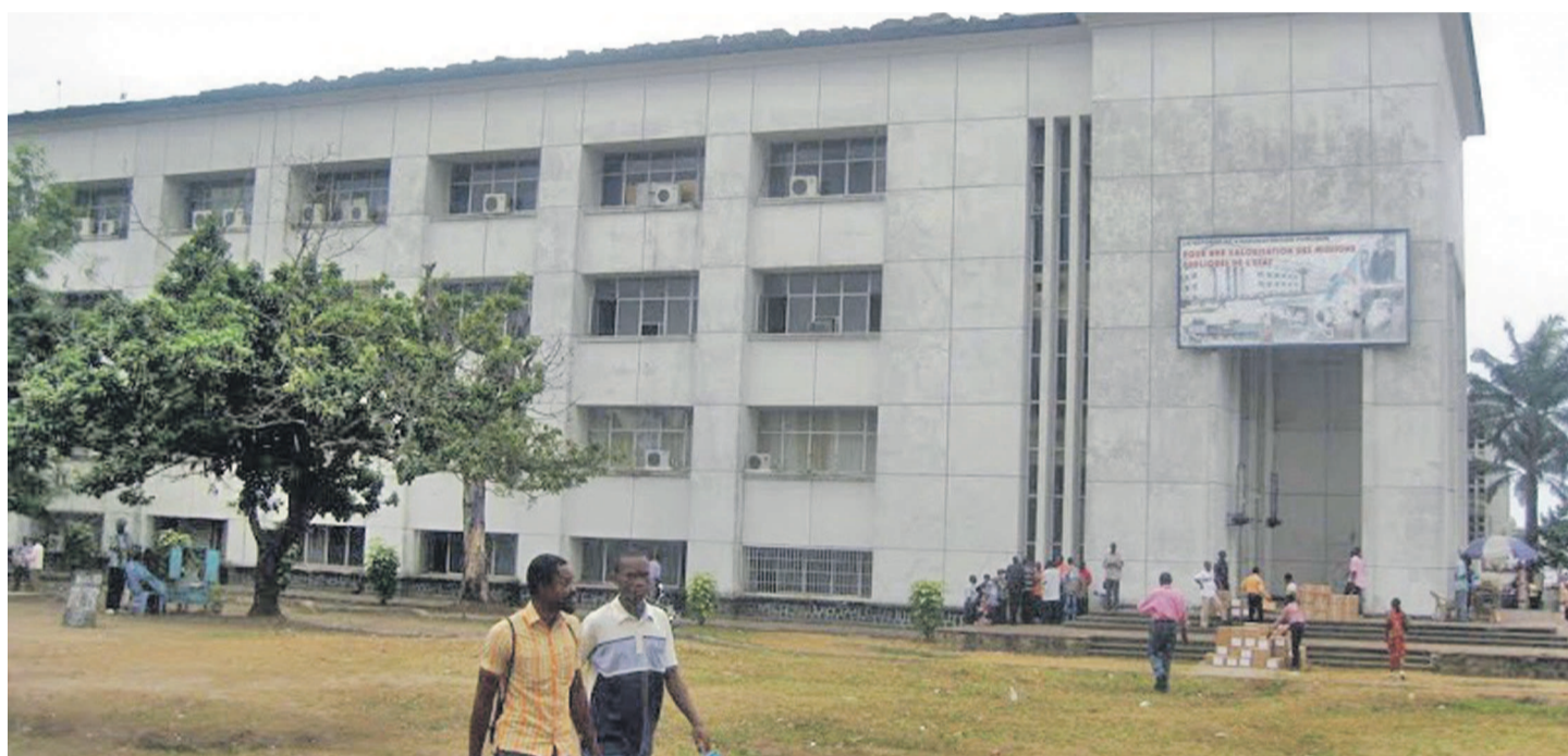
Une vue du bâtiment de la Fonction publique
