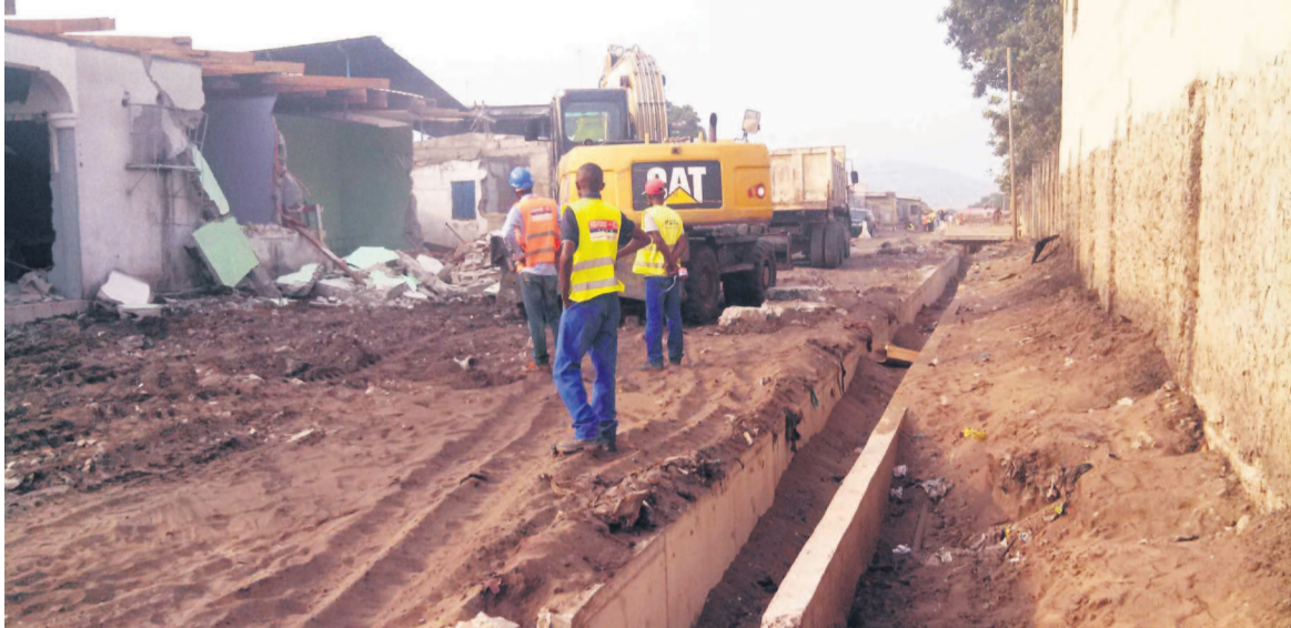
Des engins à pied d'oeuvre
