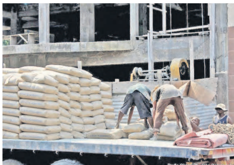
Déchargement des sacs de ciment Cilu dans un chantier/Photo John Bompengo-RO
