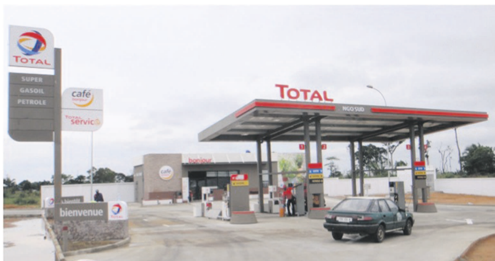
Vue de la station Total NGO SUD
