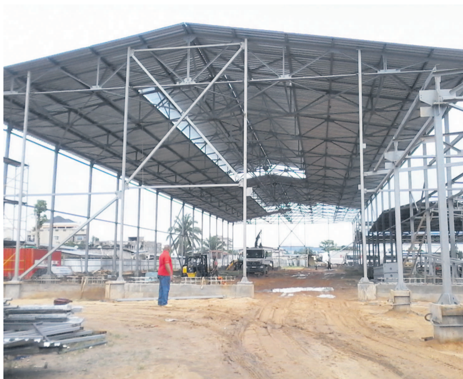
Un hangar de l'usine en cours de montage
