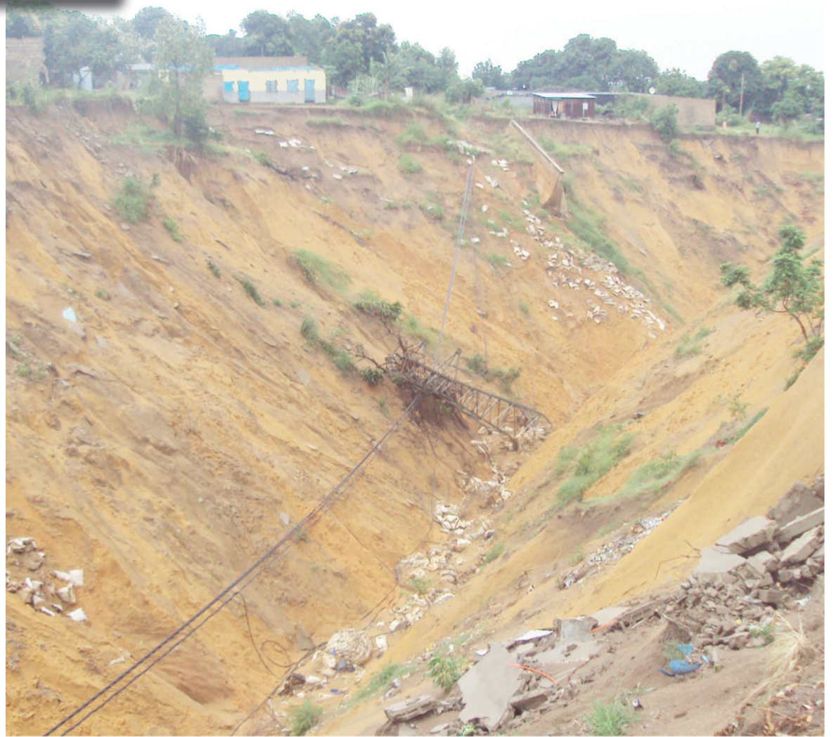
L'érosion a rasé un pylône, sectionnant les câbles/crédit photo Adiac
