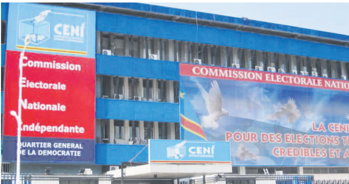
Le siège de la Ceni sur le boulevard du 30 juin
