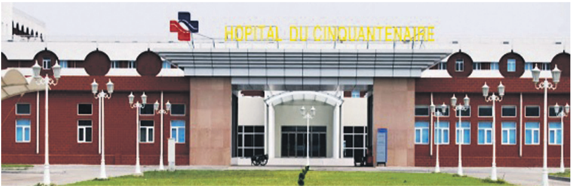
Hôpital du Cinquantenaire
