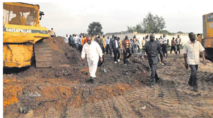
Roland Bouiti-Viaudo pendant la visite des chantiers «adiac»
