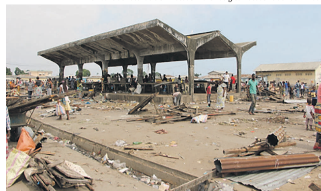
Le marché Tié-Tié Massola après sa démolition / crédit photo «ADIAC»
