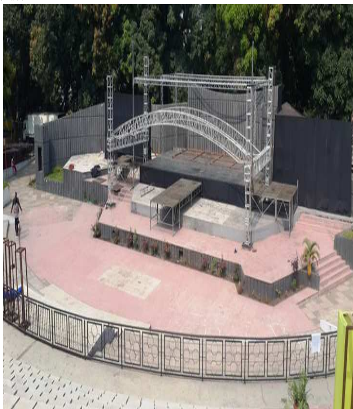
Vue frontale du podium qui devait accueillir le concert de Stromae
