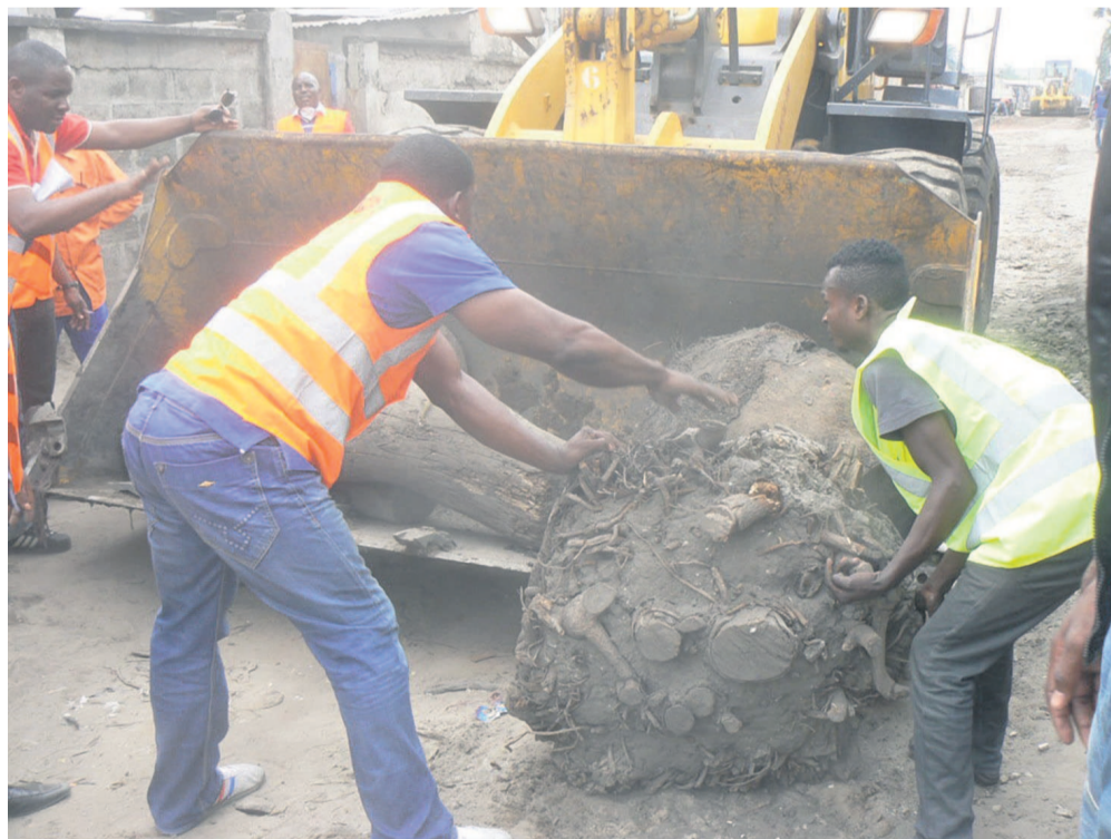
Un engin collecteur des troncs d'arbres et épaves de voitures se trouvant sur la chaussée (adïac)
