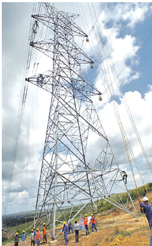
Montage de la deuxième ligne haute tension Inga-Kinshasa
