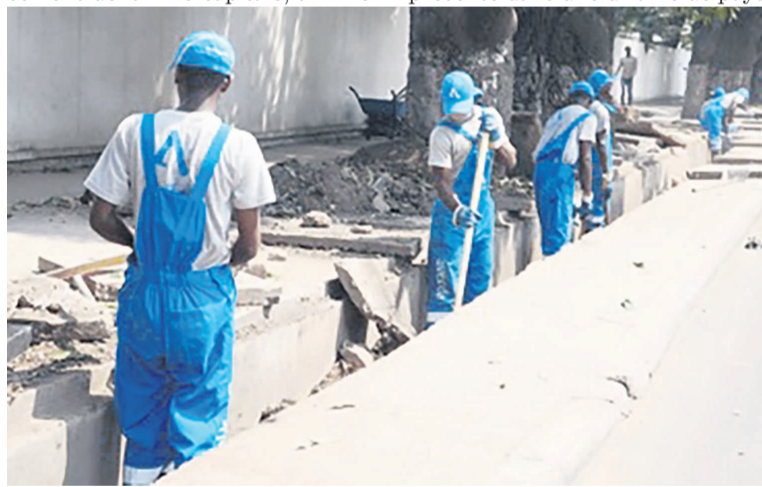
Curage d'un caniveau au centre-ville de Brazzaville par les ouvriers de la société Averda
