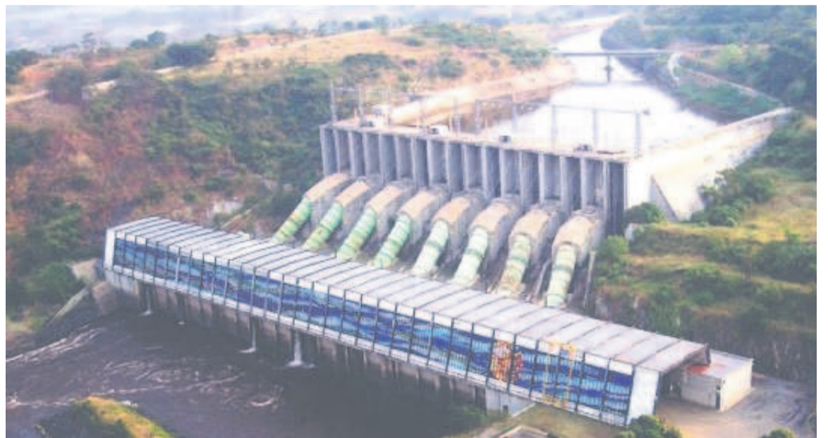
Le barrage Inga III toujours en chantier
