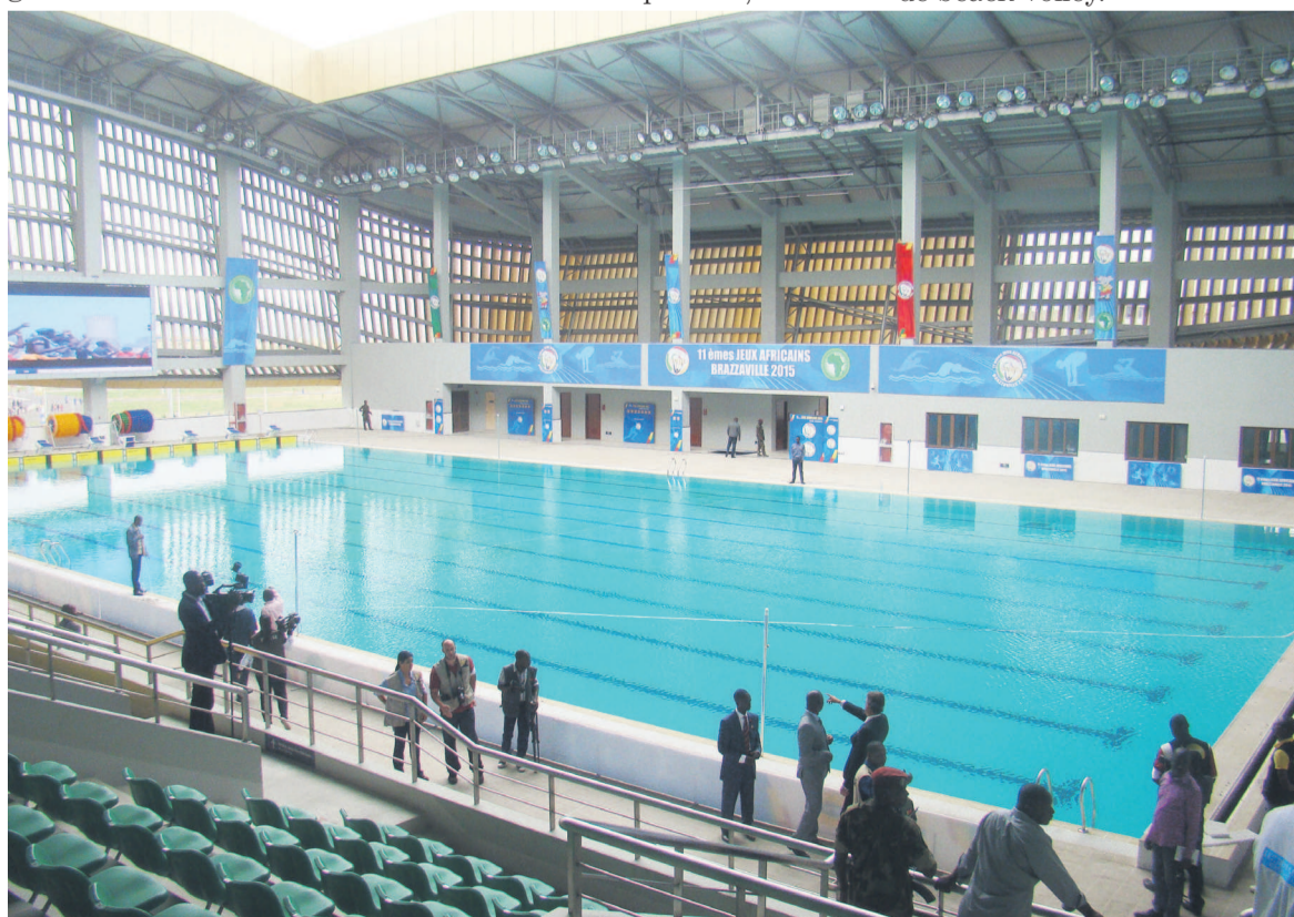
Complexe nautique vue de l'intérieur
