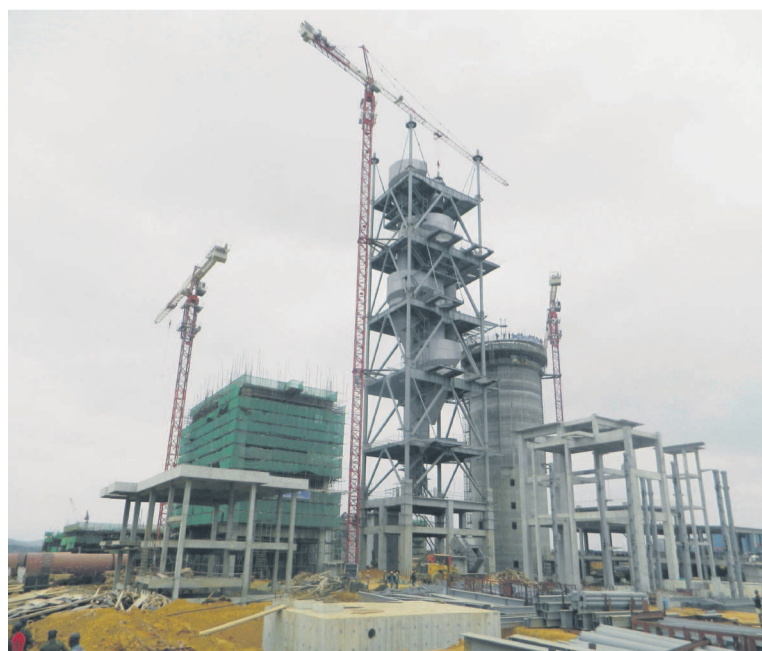
La cimenterie de Yamba en travaux
