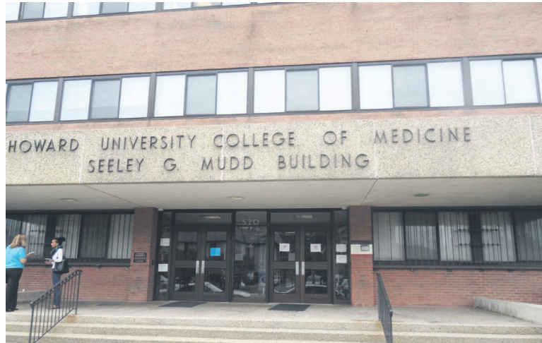
Façade principale du centre
