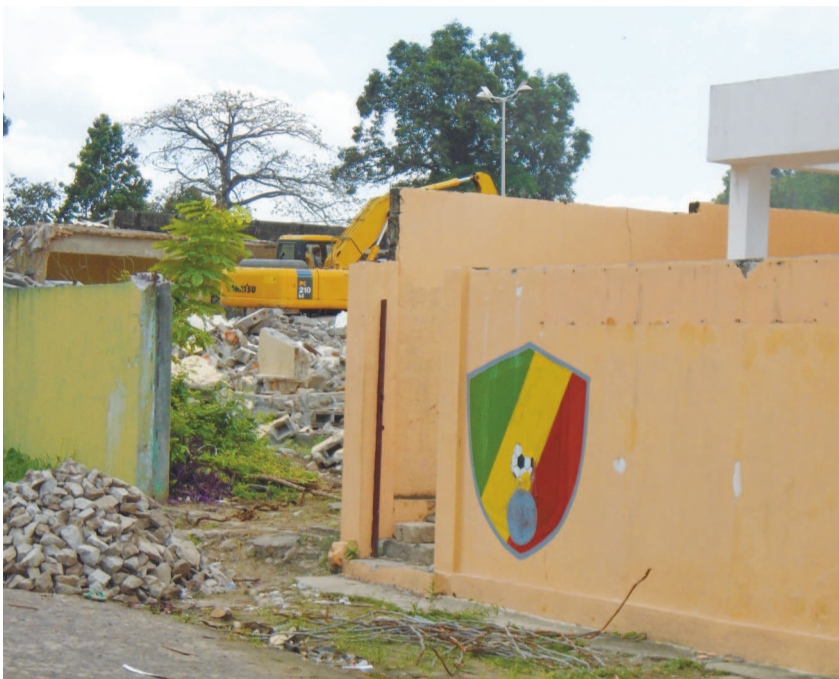
L'ancien siège de la Fécofoot démolli (Photo Adiac)
