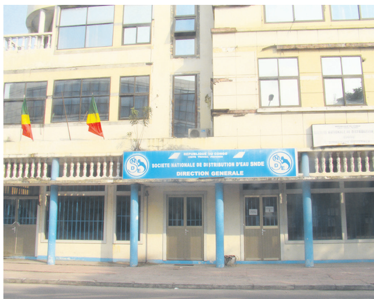
La façade principale de la Direction générale de la SNDE
