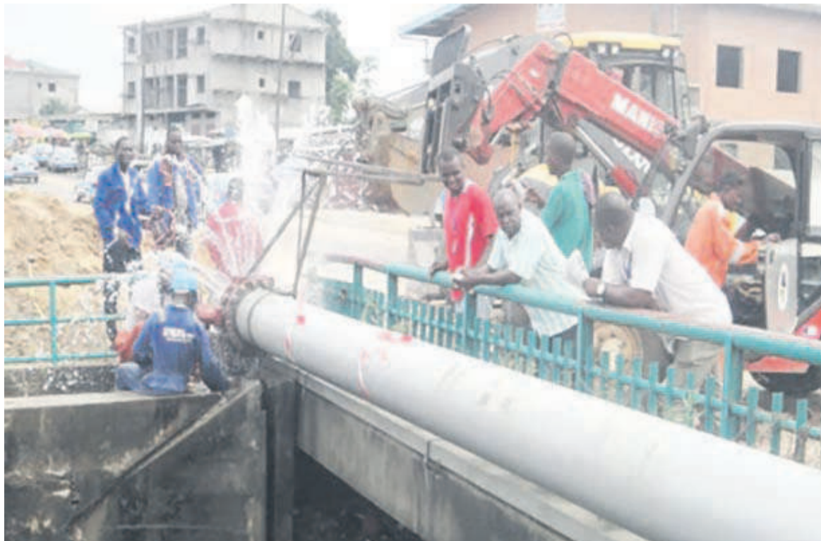
La conduite d'eau en réparation/Photo Adiac
