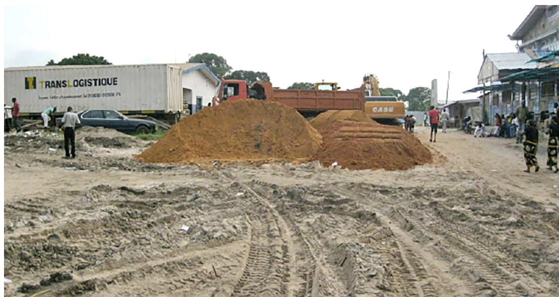
Les travaux d'aménagement sur l'avenue Émile-Biyenda Crédit photo: Adiac»
