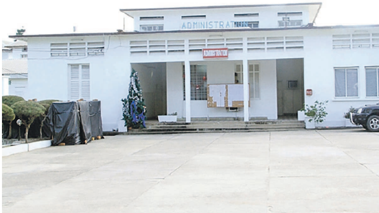
Le bâtiment administratif de l'hôpital général Adolphe-Sicé crédits photos «DR»
