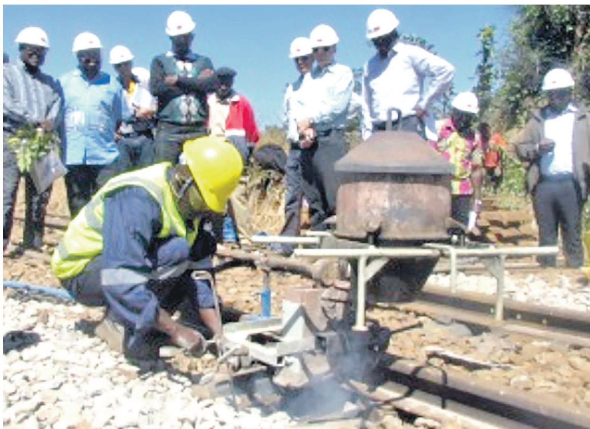
Renouvellement de la voie ferrée
